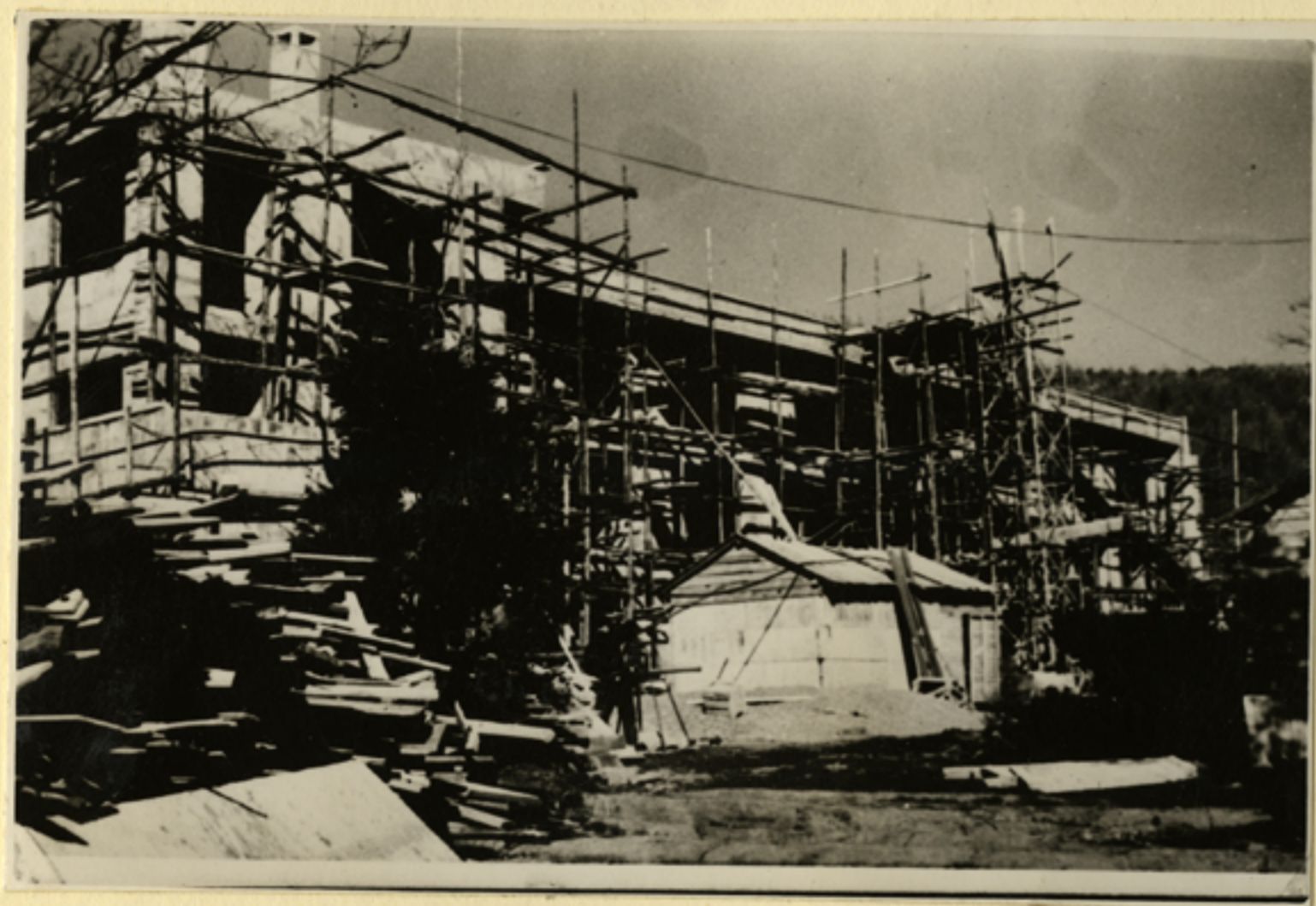
13 智明寮建築工事
