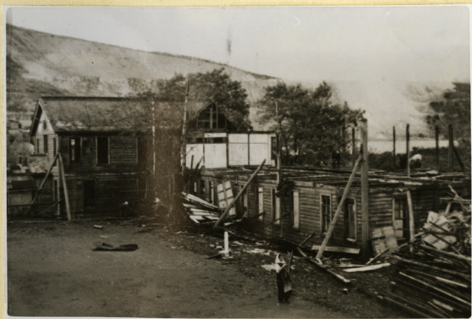
14 杓寮(北斗寮)解体工事
