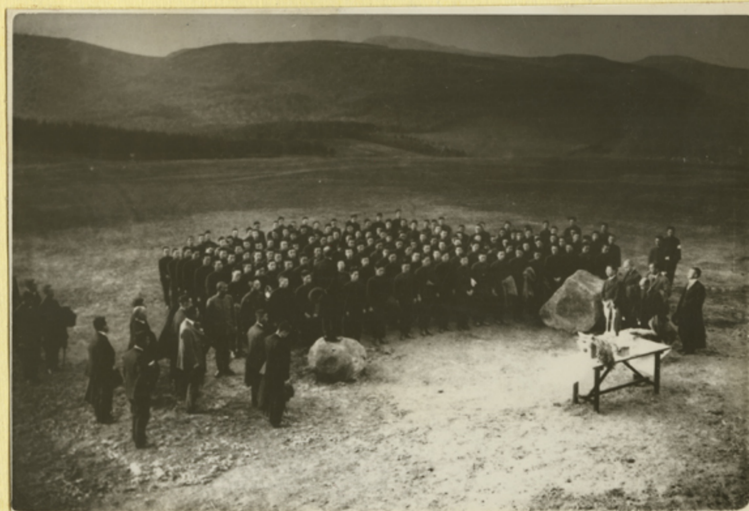
54 山上グラウンド竣工式 (大正14年11月)
