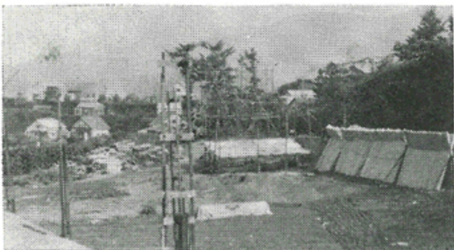
8月15日をめざし慰霊碑の建設が進む
