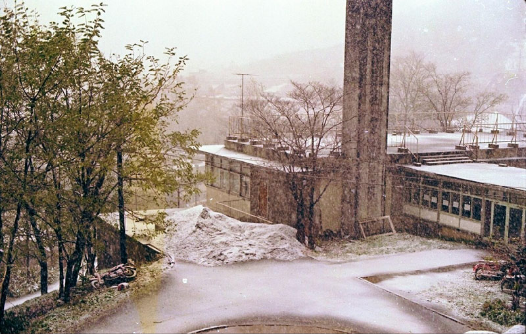
旧棟から食堂方面。寮は石炭ボイラーでした。
