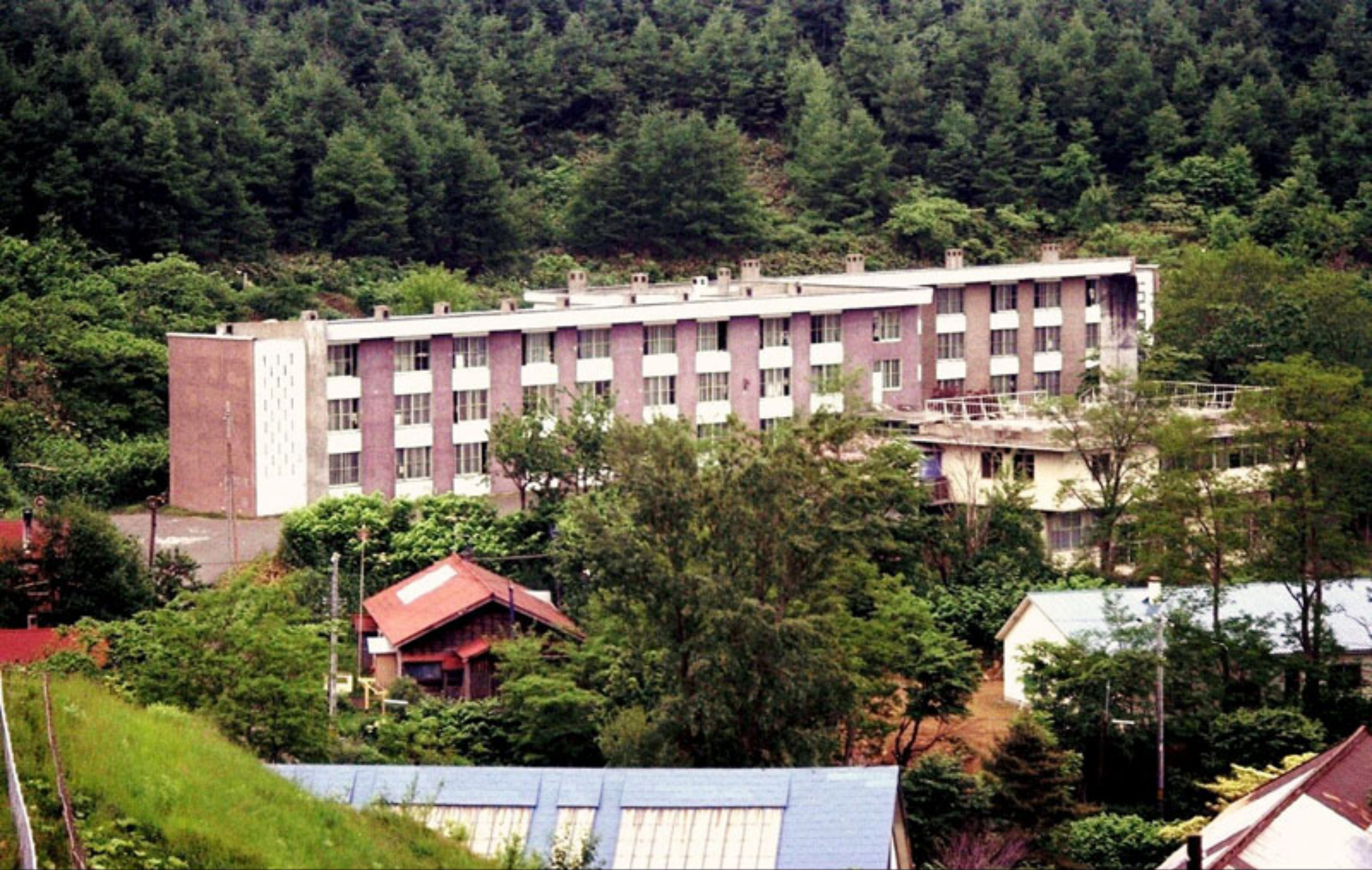
智明寮の全景。右側に突き出ているのは食堂でその下に風呂場とボイラー室がありました。
