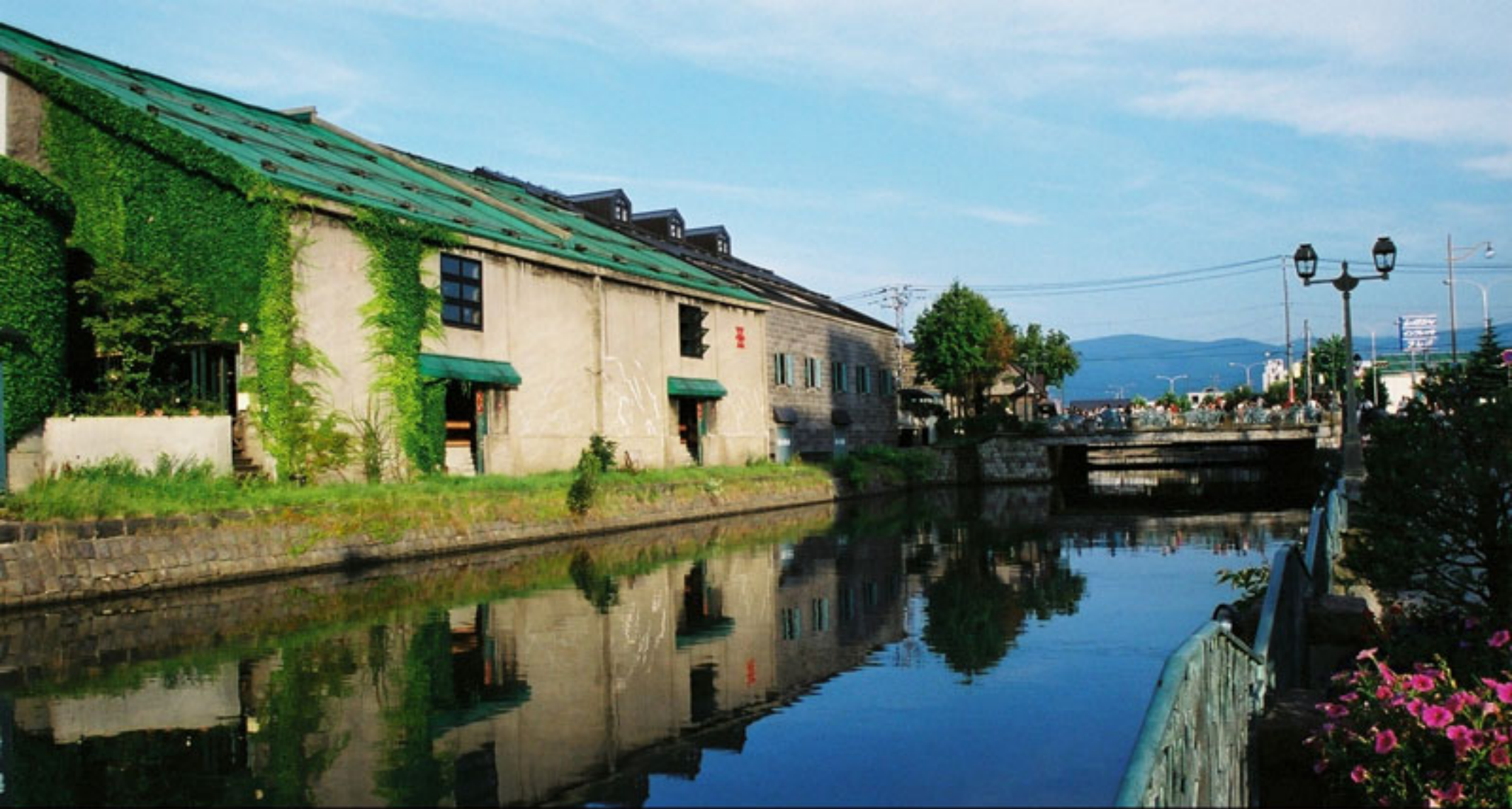
平成13年8月小橋運河沿いの散策路から浅草橋、観光案内所方面。
