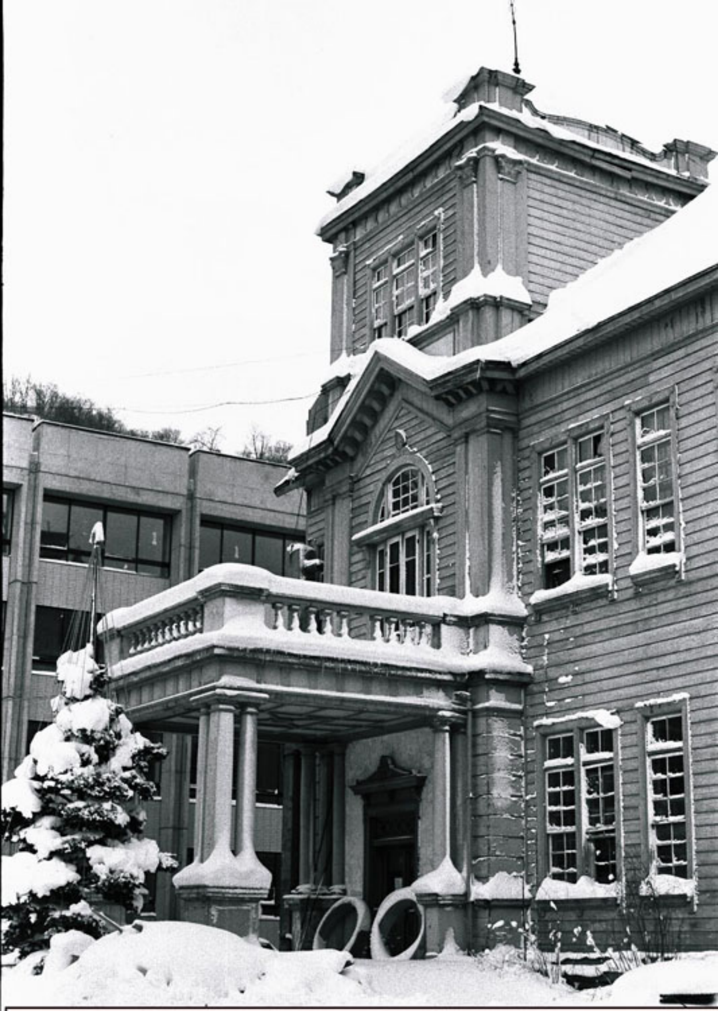
昭和47年冬の旧校舎。コンクリート校舎にはない趣がありました。
