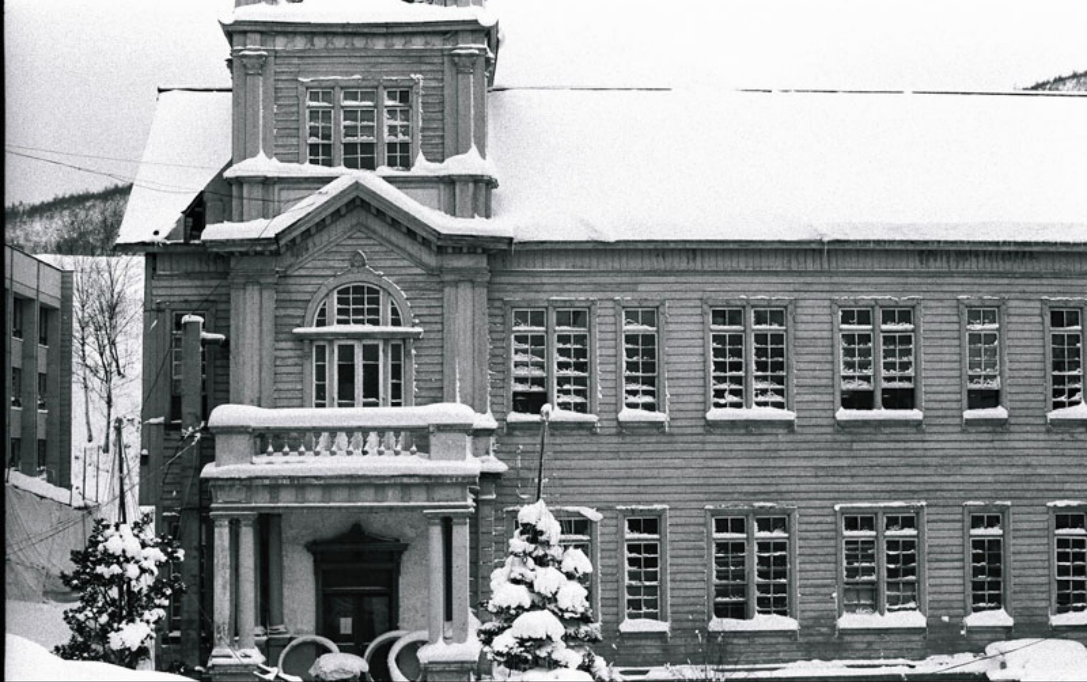
昭和47年冬には旧校舎は半分取り壊されていましたが、でも、残った部分ではまだ授業もしていました。
