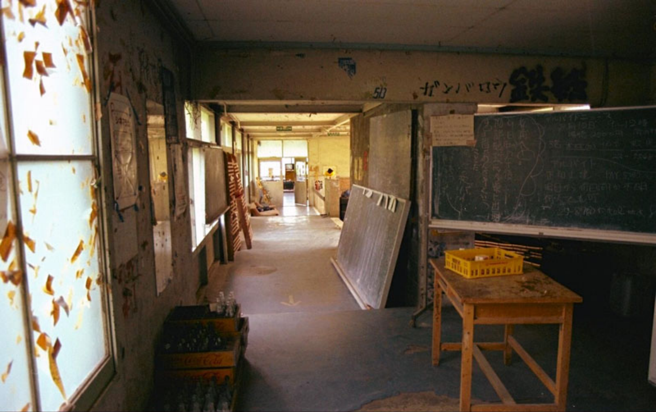
新棟、旧棟と食堂を繋ぐ渡り廊下。これがなければ吹雪の日、食堂・風呂に行けません。
