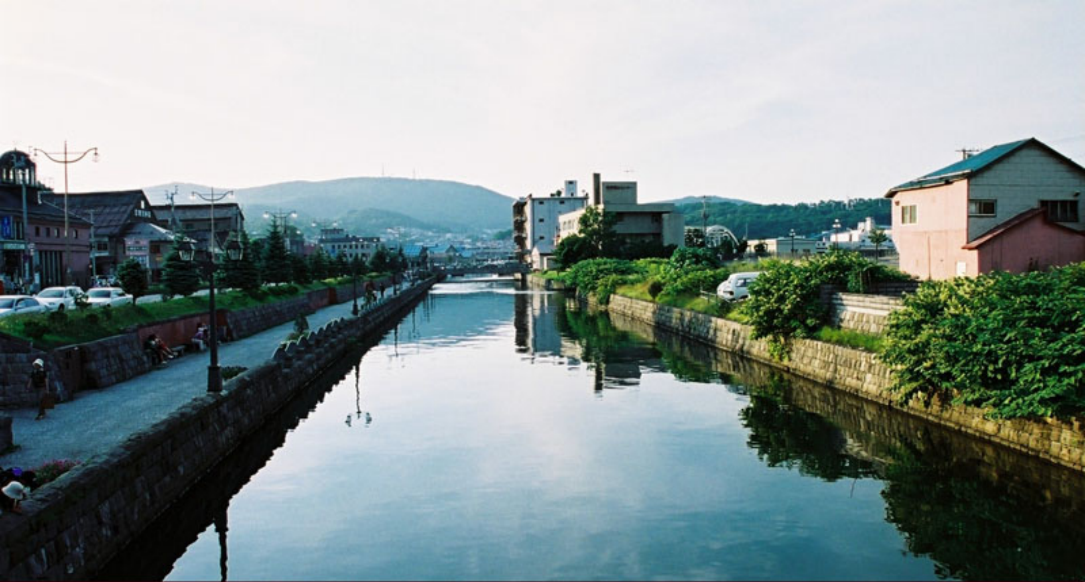
平成13年8月中央橋から竜宮橋、北運河方面。少しアップにしました。
