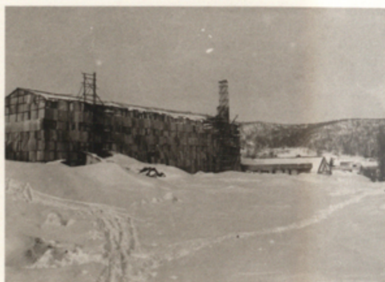
工事中の研究室
