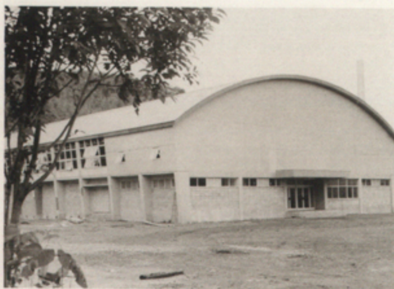
新装の体育館
